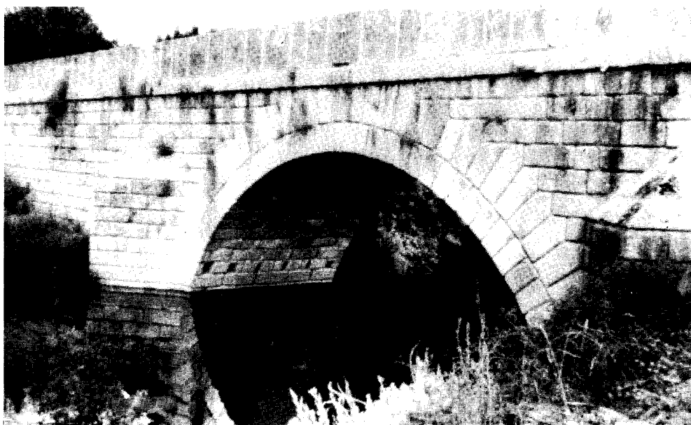
Fig. 4: El puente de las Parrillas (1580-1583) fue construido sobre el río Guadarrama por Juan de Herrera durante los trabajos de construcción del Monasterio de El Escorial. Tiene dos parrillas esculpidas en granito con la misma planta arquitectónica del Monasterio.
